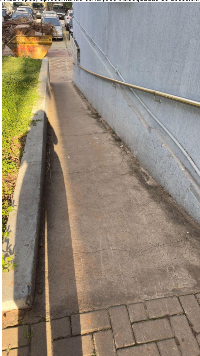
Figura 14: Rampa irregular no acesso entre o Prédio Escolar e o estacionamento de veículos da Rua Alpes, apresentando condições inadequadas de acessibilidade.
